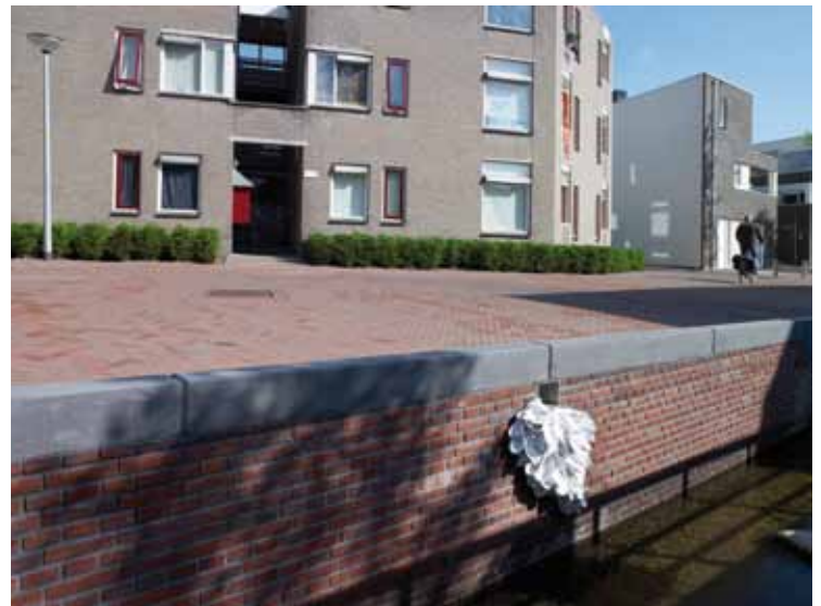
De inpassing van de beek in de Beurttvaartstraat was architectonisch een kleine ingreep, maar betekende een maximaal effect op de beleving van de stad. Beeldend kunstenaar Tanja Smeets ontwierp de 23 'waterspuwers' waaruit regenwater wordt afgevoerd en de beek instroomt.
