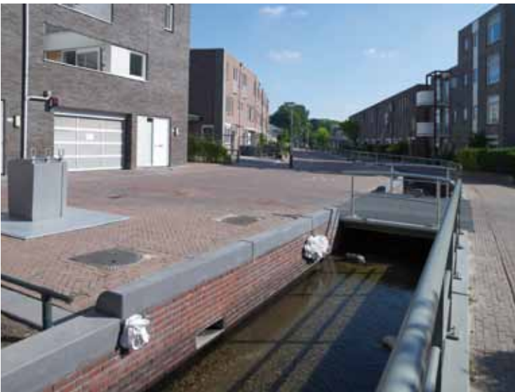
De inpassing van de beek in de Beurttvaartstraat was architectonisch een kleine ingreep, maar betekende een maximaal effect op de beleving van de stad. Beeldend kunstenaar Tanja Smeets ontwierp de 23 'waterspuwers' waaruit regenwater wordt afgevoerd en de beek instroomt.
